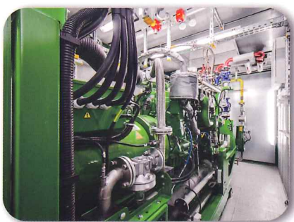
水素発電設備 agenitor 406 (コンテナ内)
