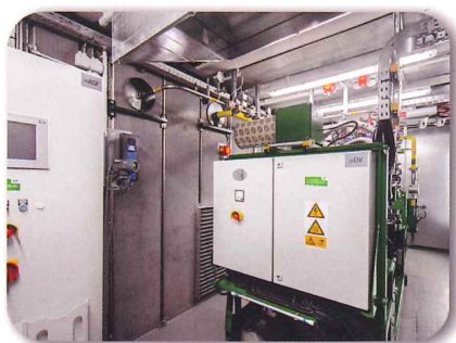
水素発電設備 agenitor 406 (コンテナ内)
